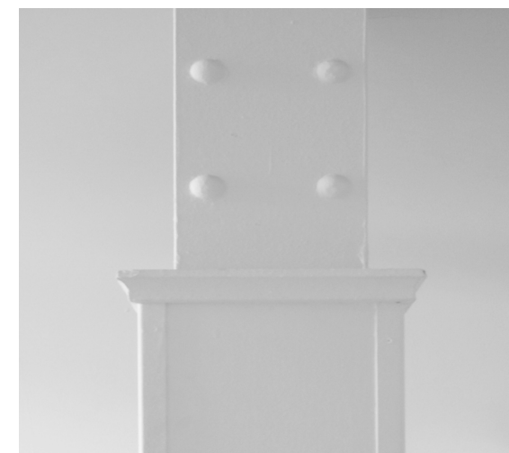
Stahlstruktur mit Brandschutzanstrich
